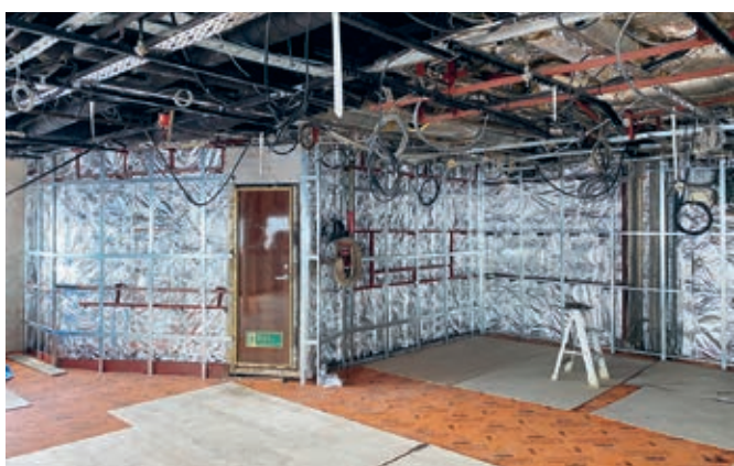
Umbau eines Sitzungsraumes auf Deck 4
